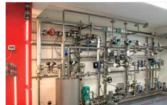
Construcción de instalaciones
