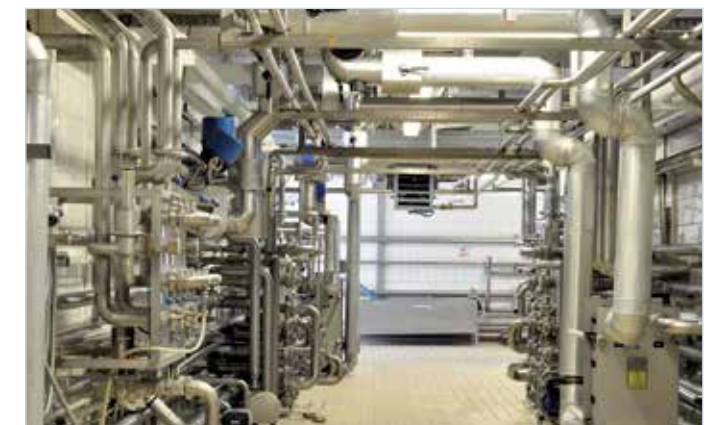
Tratamiento de agua
